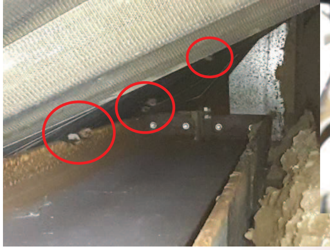
Chiroptères en gîte nocturne sous l'estacade Pech rive Gauche
