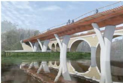
Perspective de la structure, des piles et de la culée C0
