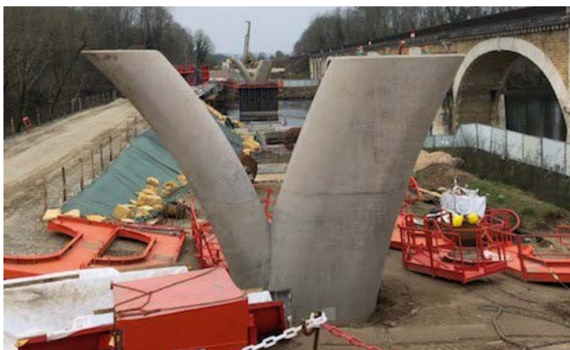
▲ Les travaux du nouveau pont à Vézac
