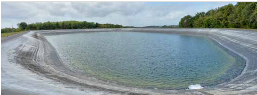
Retenue de substitution du bassin versant du Bandiat sur la commune de Varaignes
