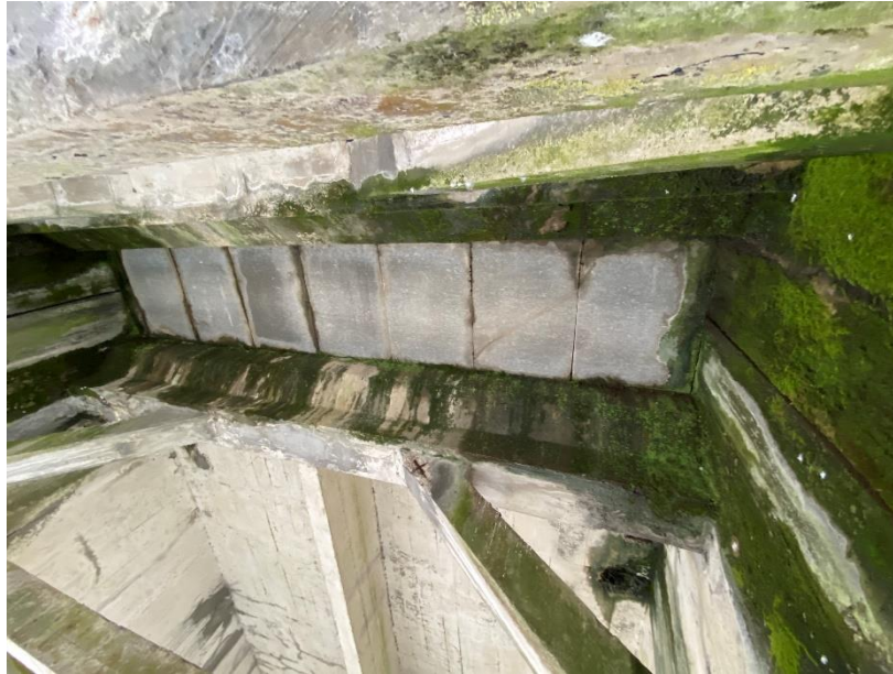
Figure 6 : Vue de l'intrados au droit du joint [Photo DIADES]
