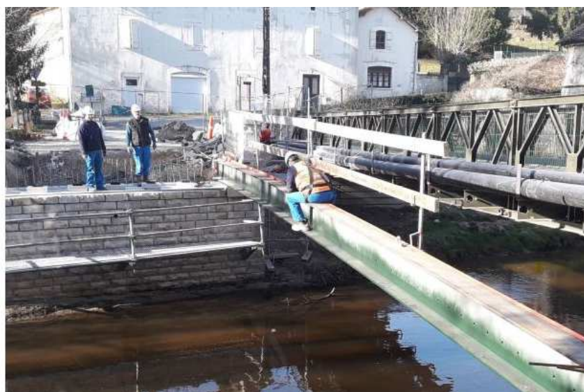
RD 93 - Pont de JAVERLHAC : Pose des poutres
