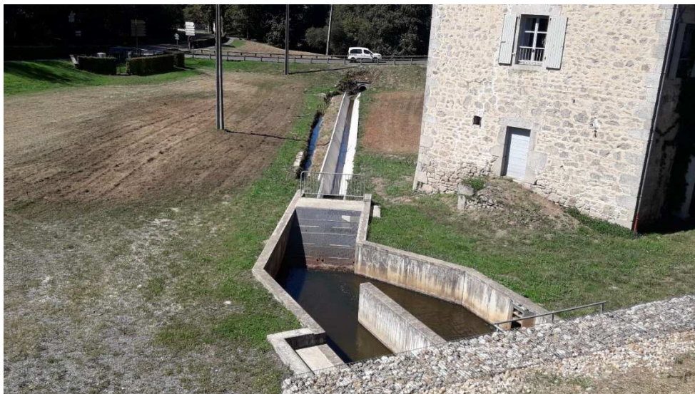
Barrage de Saint Estèphe – Nouveau chenaux en aval de la pêcherie
