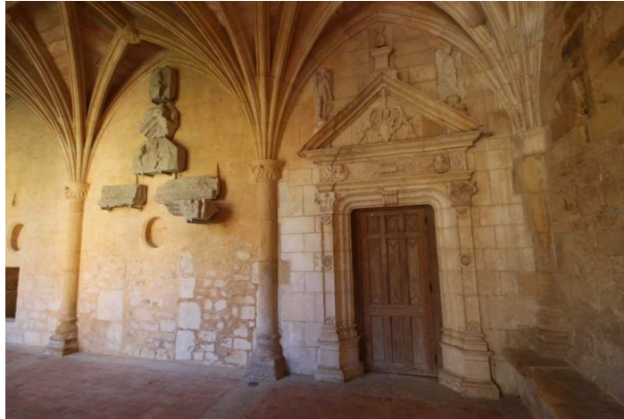
Cadouin, Cloître, Porte de la galerie ouest avec fragments originaux du XVI e siècle restaurés remontés en anastylose
