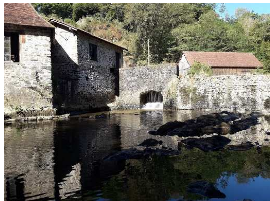
Vue du seuil du barrage et de la restitution par la vanne
