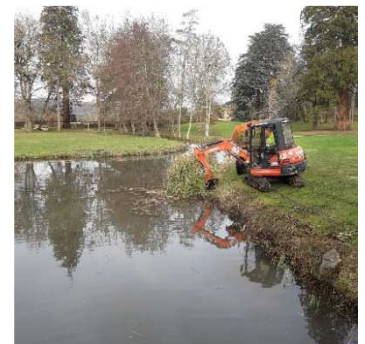
Intervention avec mini-pelle et godet peigne - décembre 2020
