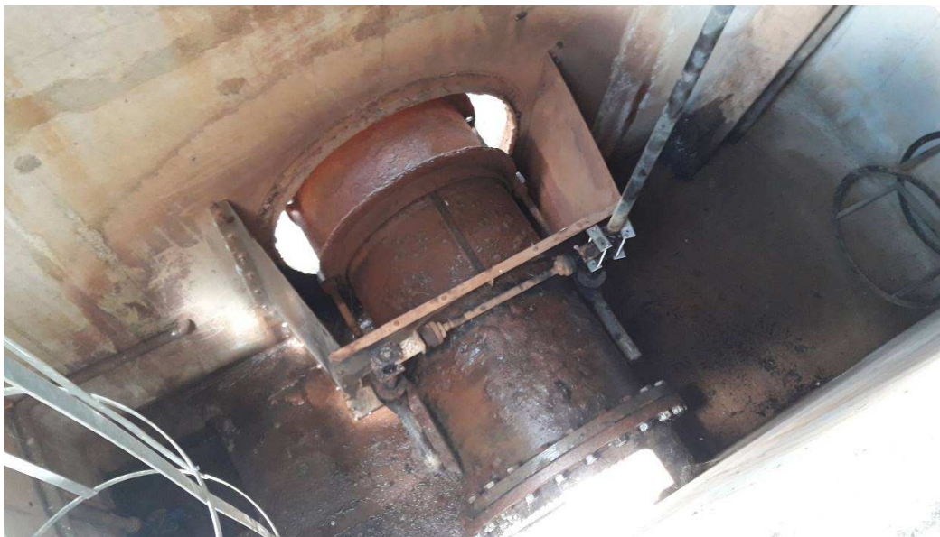
Vanne jet creux du barrage de Miallet
