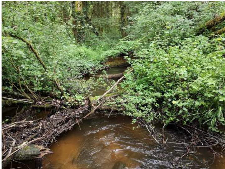
Portion de la Doue avant travaux
