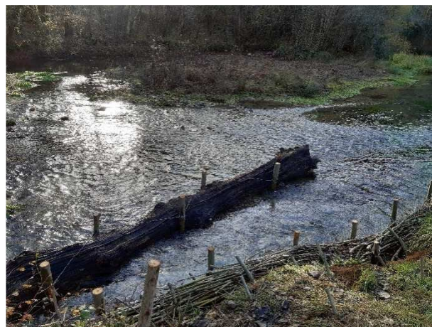
Epi et protection de berge par fascinage sur le Coly
