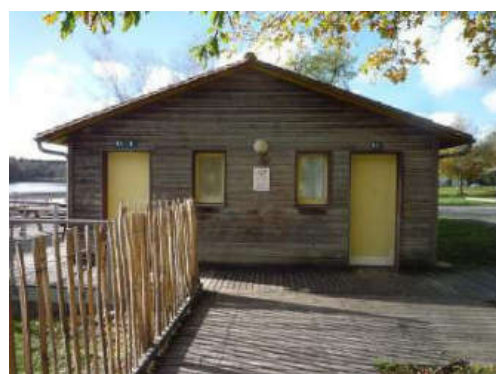
Accès sanitaires bloc Est
