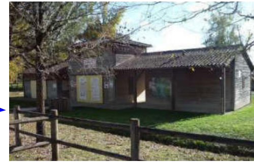
Le poste d'accueil
