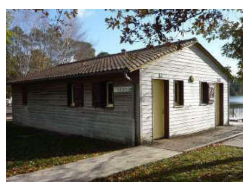
Accès sanitaires bloc Ouest
