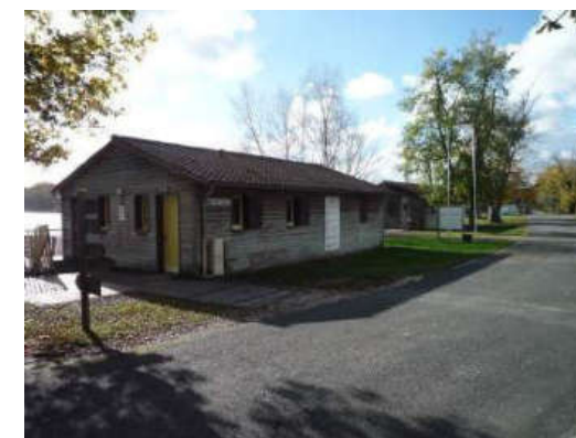
Le bâtiment sanitaires/commerce côté Est
