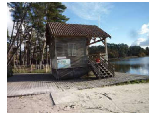
Le poste de secours vu au Nord-Ouest
