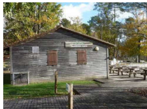
Restaurant "côté plage" façade Ouest
