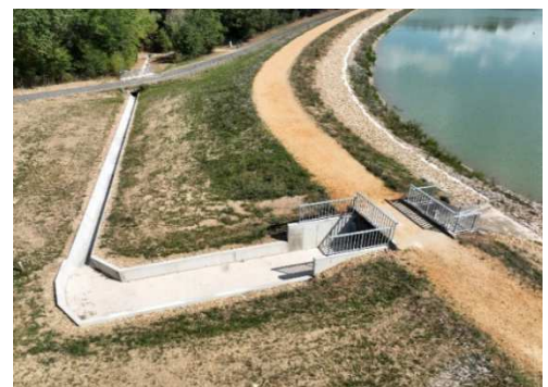
Evacuateur de crue, coursier, parement amont réhabilités
