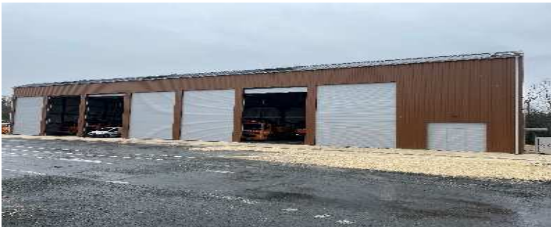
Ombrière et bâtiment de stockage de matériel et autres engins de TP
