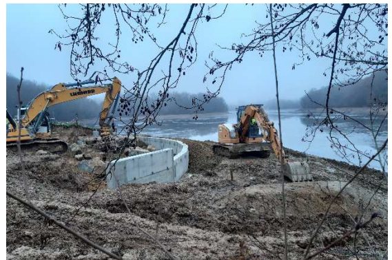
Travaux de l'évacuateur de crue en cours
