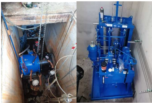
Pose de la nouvelle vanne annulaire et commande motorisée des vannes
