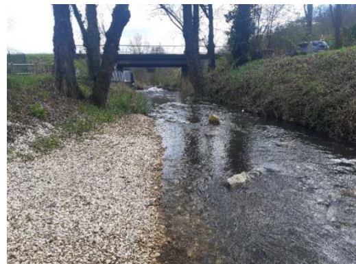
Travaux de restauration du Manoire par recharge granulométrique et création de déflecteurs en tressage végétal effectués par le SMB Isle à Boulazac-sur-Manoire
