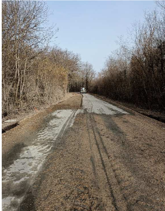
Retraitement en place
