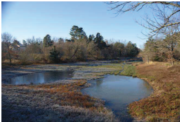
Photo 9 - En cours de travaux : création de 2 mares
