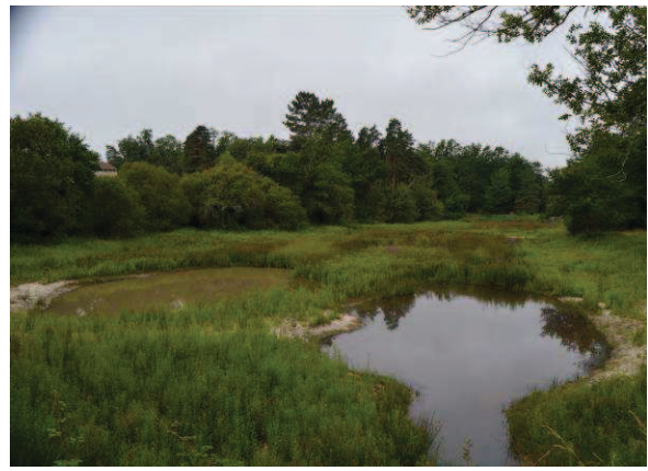
Photo 10 - Fin des travaux : végétalisation autour des mares
