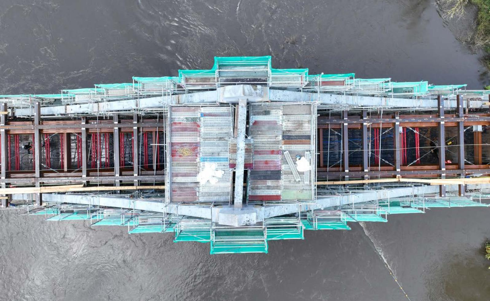
et des culées) exécutés, il a été procédé au délançage de la charpente (retour en berge) pour y être mise dans sa configuration définitive. Il s'agit d'élargir l'entraxe des poutres par allongement des entretoises avant de relancer la charpente dans sa configuration définitive de 6 mètres de large.
