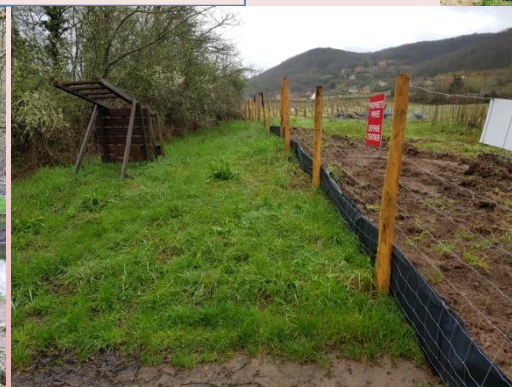
Clôture de chantier et mise en défens
