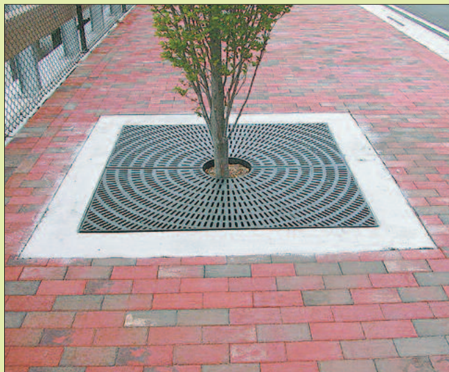
Protection : grille métallique
