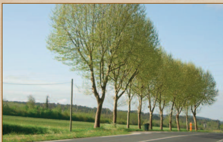
Taille de remontée de couronne RD 6089 à RAZAC SUR L'ISLE
