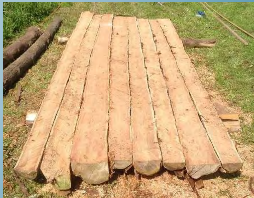
exemple de platelage rustique en rondins
