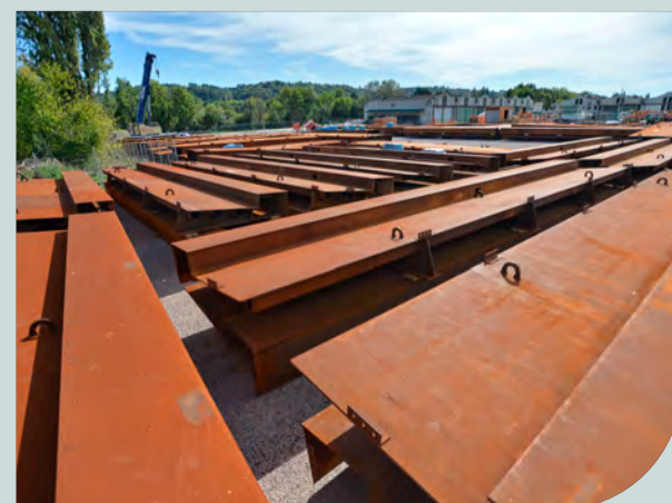
Tabliers du pont payés et entreposés à Marsac-sur-l'Isle
