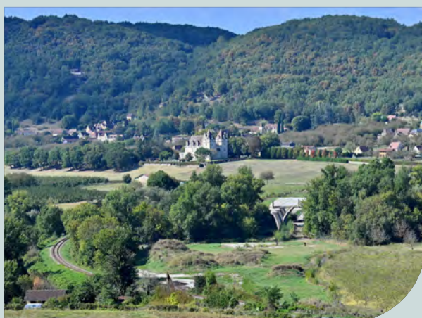
Piles du pont Joséphine Baker
