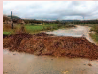
Accès chantier bloqué par merlon de terre
