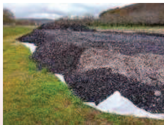
stockage matériaux de démolition / remise en état RD53
