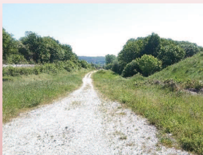
Repousse de la végétation Fayrac rive gauche
