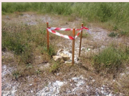
Balisage trou de forage Pech rive gauche
