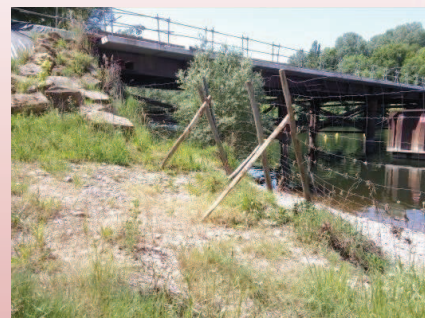
Clôture en limite d'emprise Fayrac rive droite
