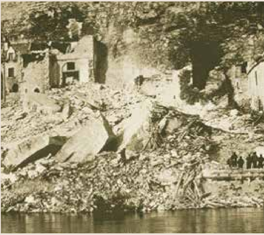
Éboulement meurtrier dans le bourg de La Roque Gageac le 17 janvier 1957, la route est fermée plusieurs mois durant.
