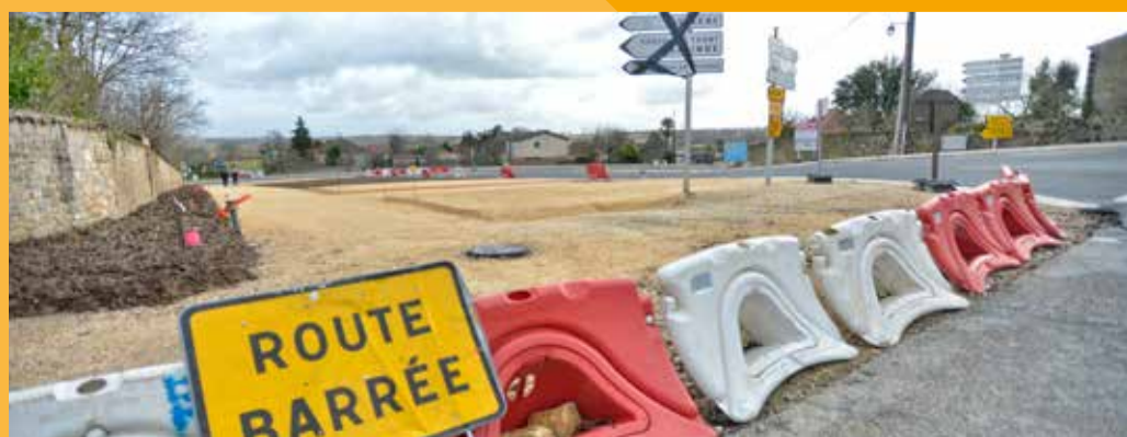
Les travaux du contournement de Beaumontois-en-Périgord
