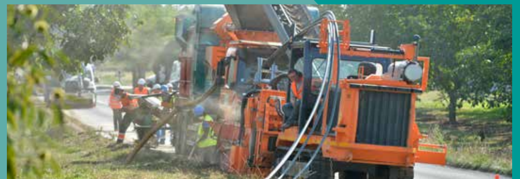
Chantier de déploiement de la fibre en Dordogne
