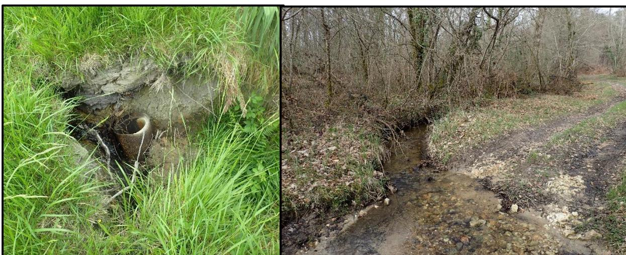
**Erosion ayant conduit à la chute de la buse (lieu-dit « Etang de Bodifer ») à gauche et passage à gué (lieu-dit « la Riboutie » à droite (BKM, 2017)**
