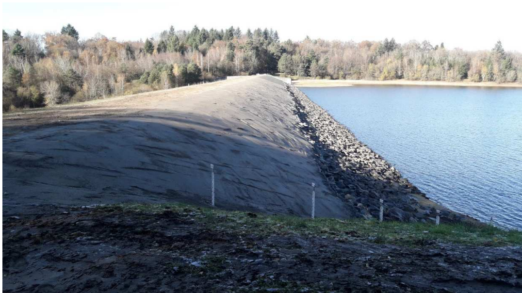
BARRAGE DE MIALLET– PREPARATION DU SOL DU PAREMENT AMONT
