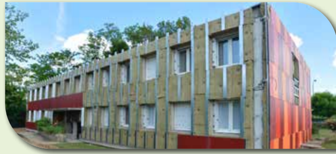
Isolation extérieure du Collège de Mussidan
