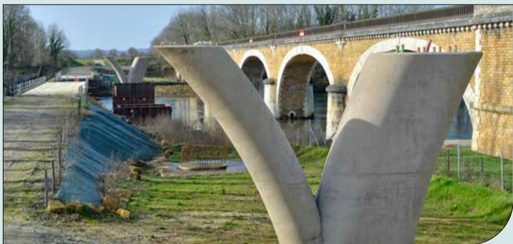
Les piles et les fondations des ponts sont réalisées
