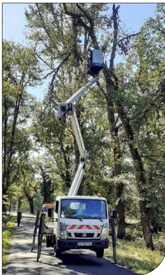
Agents du Département dégageant les routes suite à l'orage du 20 juin 2022.
