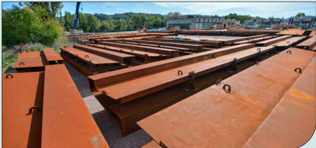
Les tabliers métalliques stockés au Parc départemental à Marsac sont prêts à être installés
