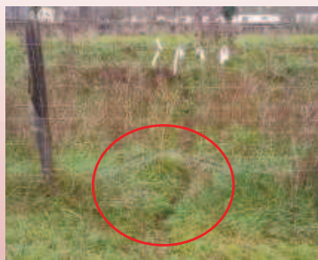
Passage de sangliers sous la clôture du dépôt de matériaux de Fayrac FSE n°28 17/12/20
