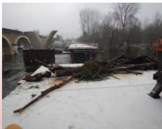
Enlèvement des embâcles au niveau des estacades métalliques Fayrac rive gauche et Pech rive droite par les services techniques du Département de la Dordogne le 12 janvier 2021 FSE n°29 19/01/21
