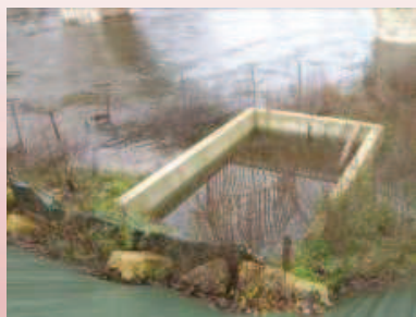
Emprise Fayrac rive droite inondée FSE n°28 17/12/20
