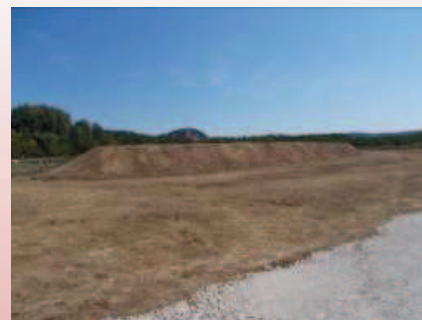
Stock de terre végétale suite au décapage emplacement du radier FCE n°2 Pra Milandes 04/09/18
