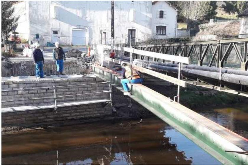
RD 93 - Pont de JAVERLHAC : Pose des poutres
