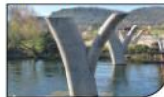
Pile du pont Joséphine Baker
