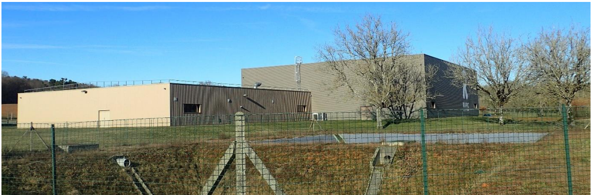
Zone d'activité de Labaurie le long de la RN21 à Eyzeraç (BKM Environnement, 2022)
