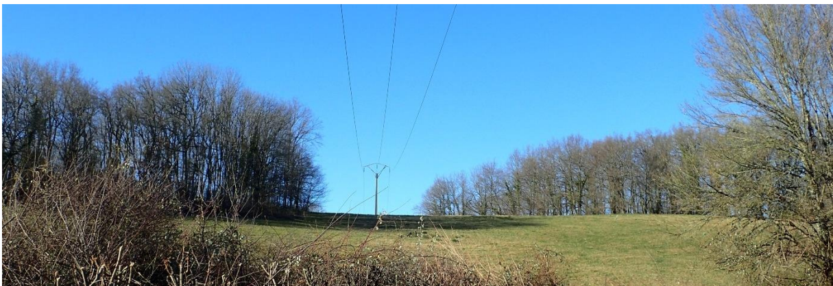
Les lignes électriques constituent un point d'appel et une ouverture dans le paysage (BKM Environnement, 2022)
