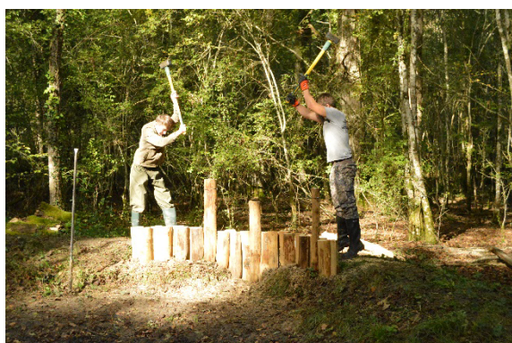
Le Parcot - Restauration d'une mare
