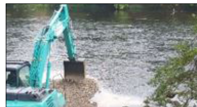
Apport de 125 m 3 de granulats sur une surface de 650 m 2 (Dordogne – Argentat),
