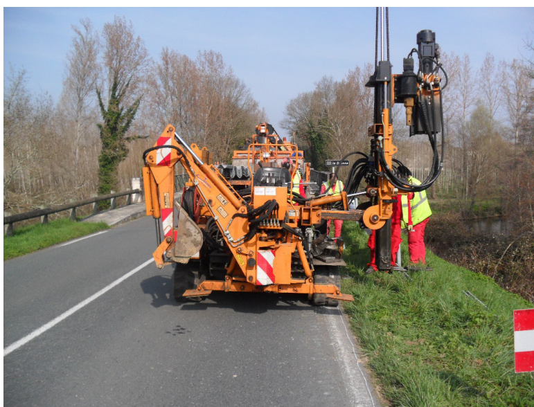
Atelier pose de glissières
