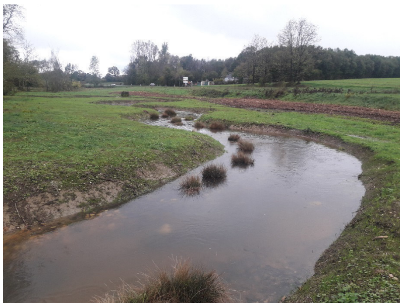
Travaux de renaturation de la Belle à Mareuil
