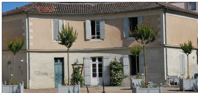
Siège du CAUE, Espace François Mitterrand, Périgueux
