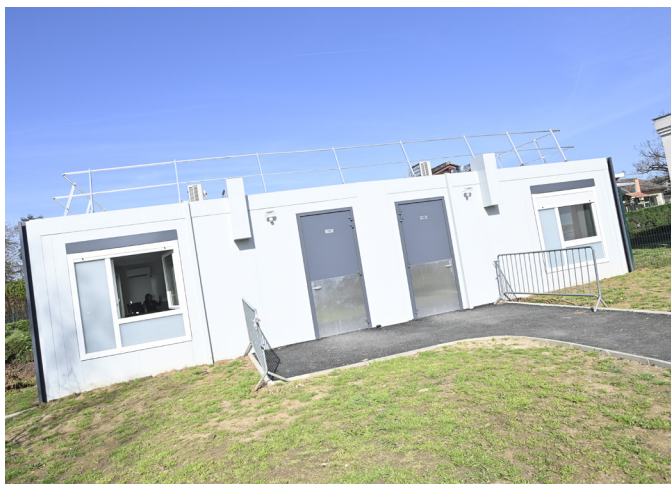
Deux nouvelles salles de classe modulaires vont être construites au collège Olympe de Gouges à Vélignes
