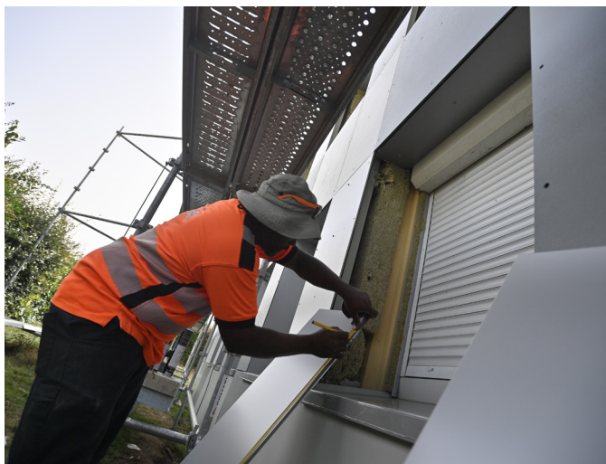
Le collège Jacques Prévert de Bergerac a bénéficié de travaux d'isolation par l'extérieur
