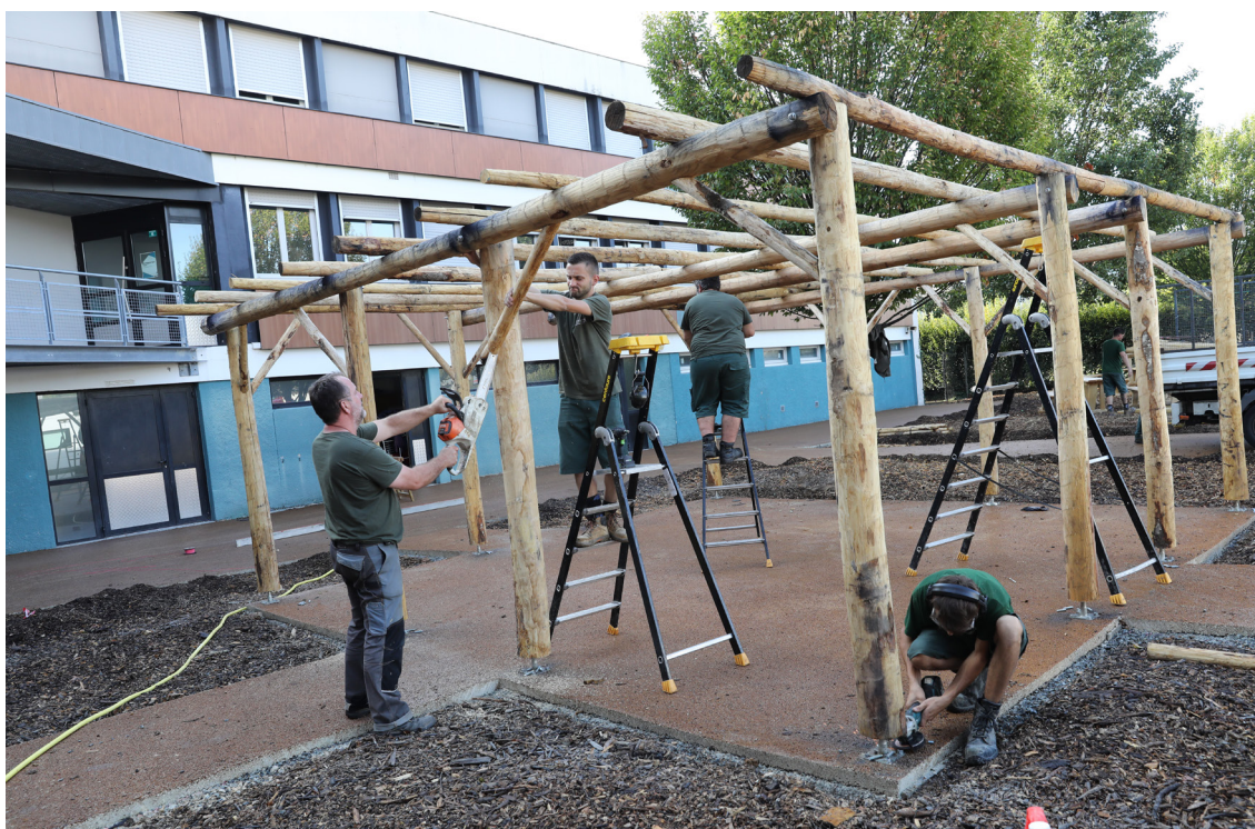
La cour du collège Michel de Montaigne bénéficie d'aménagements permettant la lutte contre les îlots de chaleur
