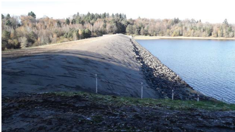
Barrage de Miallet– Préparation du sol du parement amont
