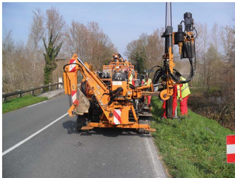
Atelier pose de glissières
