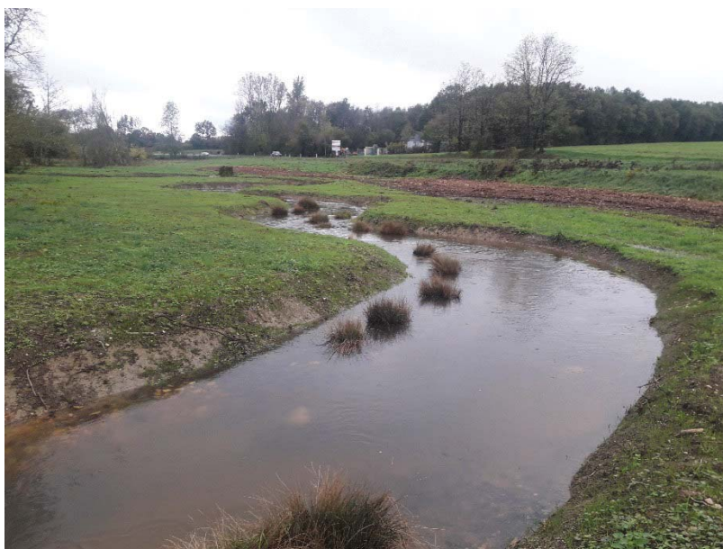
Travaux de renaturation de la Belle à Mareuil
