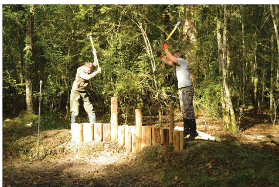
Le Parcot - Restauration d'une mare
