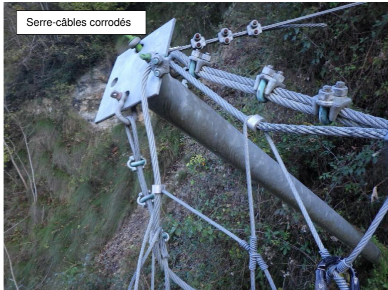
Barre corrodée- câble amont libre Et hauban rompu
