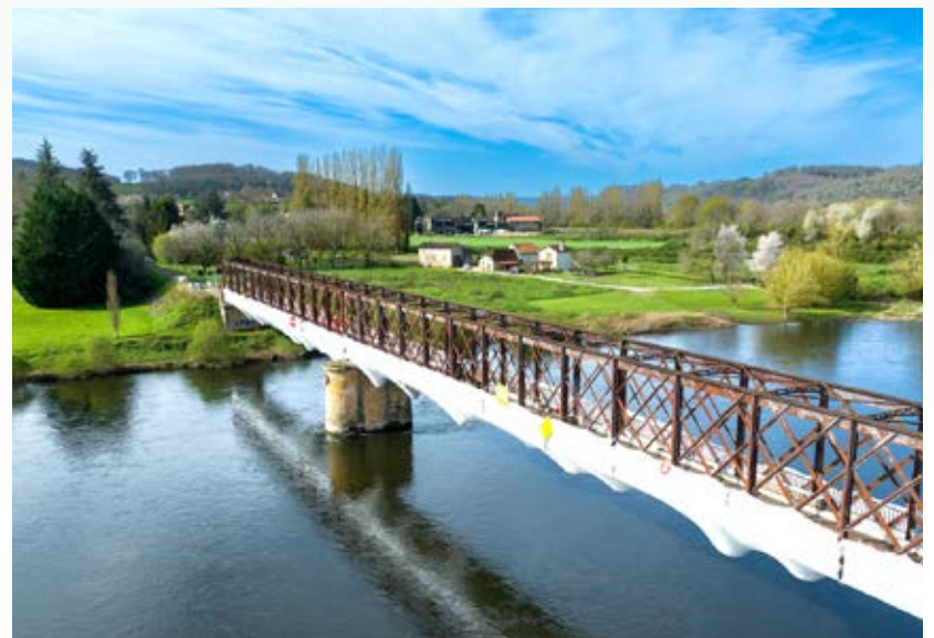
Pont métallique de style Eiffel, le pont du Garrit enjambe le Dordogne entre les communes de Saint-Cyprien et Berbiguières. Ouvert exclusivement à la circulation des vélos et des piétons, il a été inauguré le 8 juin 2024 après 5 mois de travaux qui ont coûté 425 506 € (TTC).
