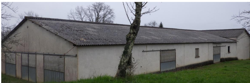
Bâtiment agricole récent (BKM Environnement, 2024)
