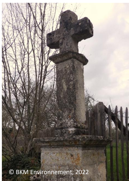
Architecture religieuse près du lieu-dit « La Nègrerie »
