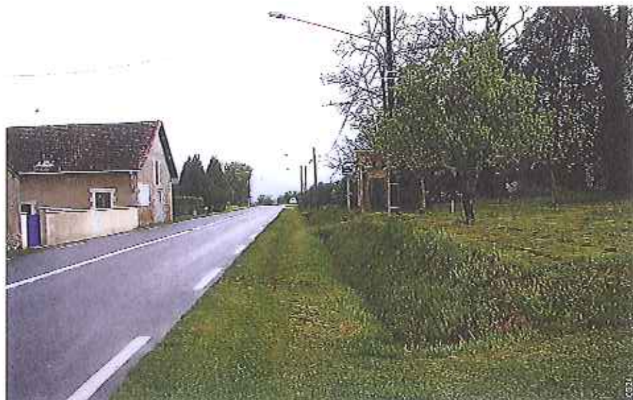
Photo 1 Un accotement et son fossé proprement fauchés, aux abords d'habitations Cleanly mown shoulder and ditch near residences
